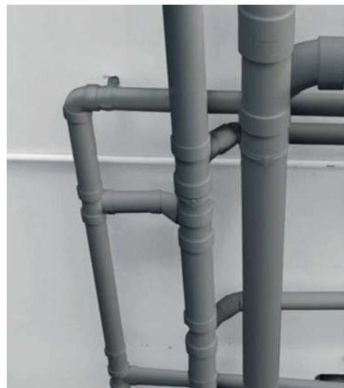
Identification des raccords: Ex : Coude 45° Ø50
